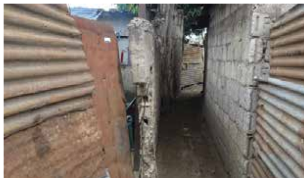
Figura 14. Callejón previo a su ensanche.
